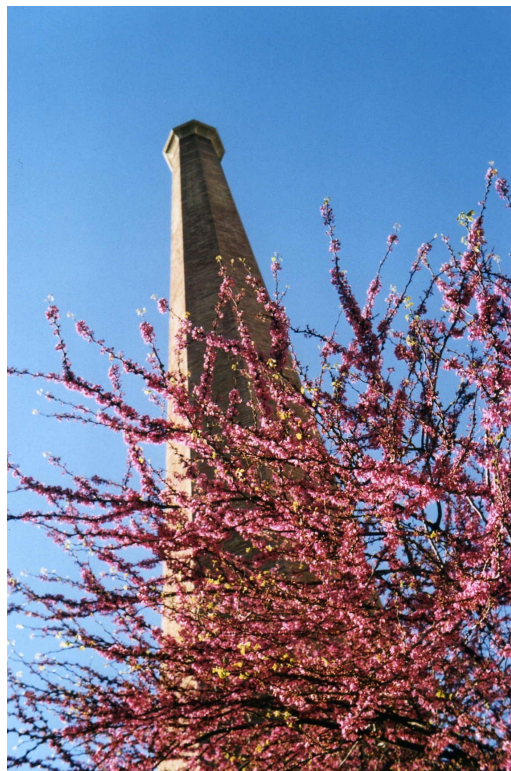
Xemeneia de l'antiga fàbrica tèxtil Batlló ubicada dins del recinte de l'Escola Industrials de Barcelona, obra de l'arquitecte Rafael Guastavino Moreno.
